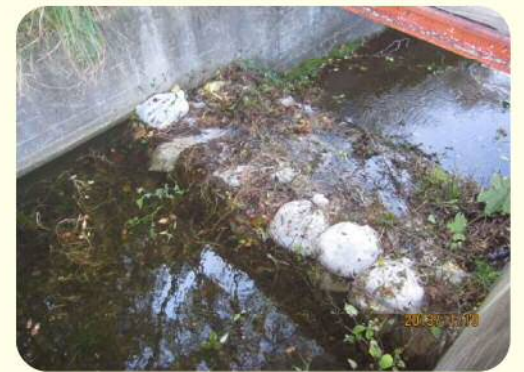
土のうによる洪水吐のかさ上げ
