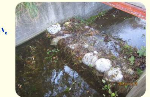
土のうによる洪水吐のかさ上げ
