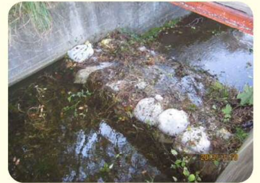
土のうによる洪水吐のかさ上げ
