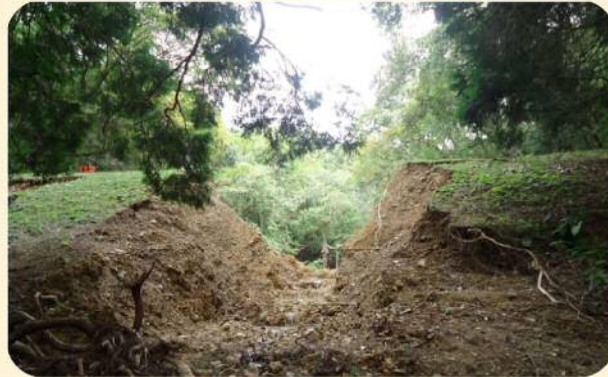
大雨により決壊したため池
