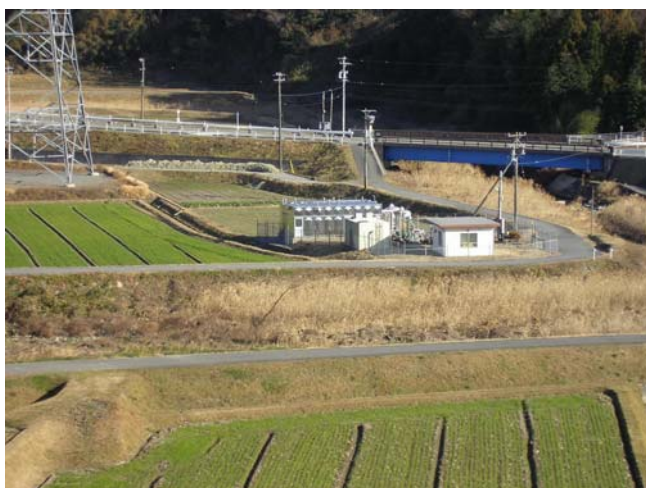
▲北部簡易水道 田辺水源・浄水場
