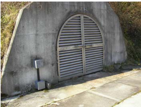
▼篠立水源取水施設入口
