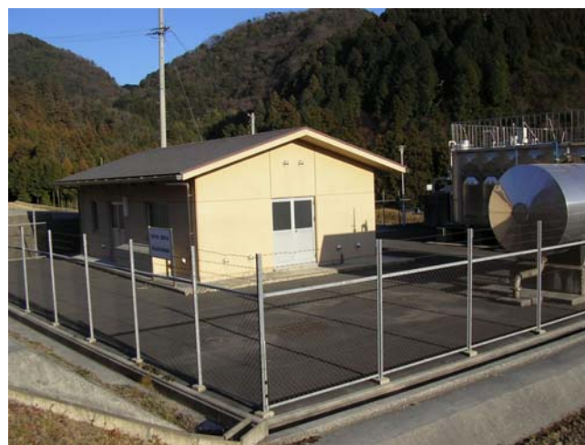
▲小原一色簡易水道 小原一色浄水場
