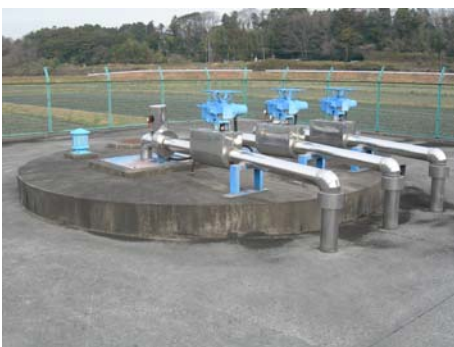
▲取水井(伏流水)
