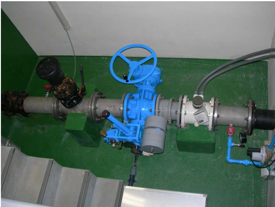
▲緊急遮断弁 設置状況
