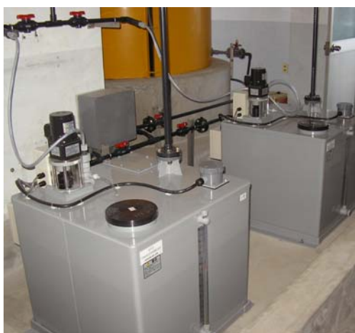
▲塩素注入設備
