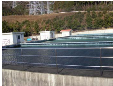
▼ろ過設備(緩速ろ過)
