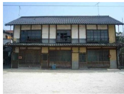
・窓が割れ、放置されている空家
