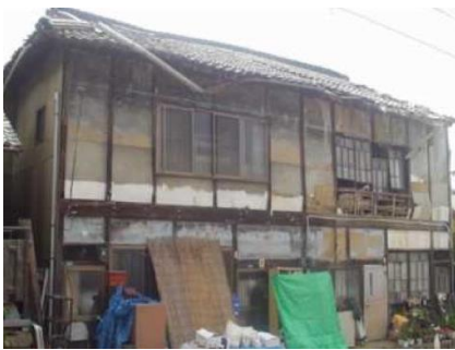
・長期間、人が住んでいない空家
