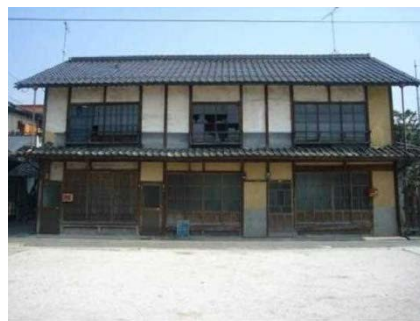
・窓が割れ、放置されている空家
