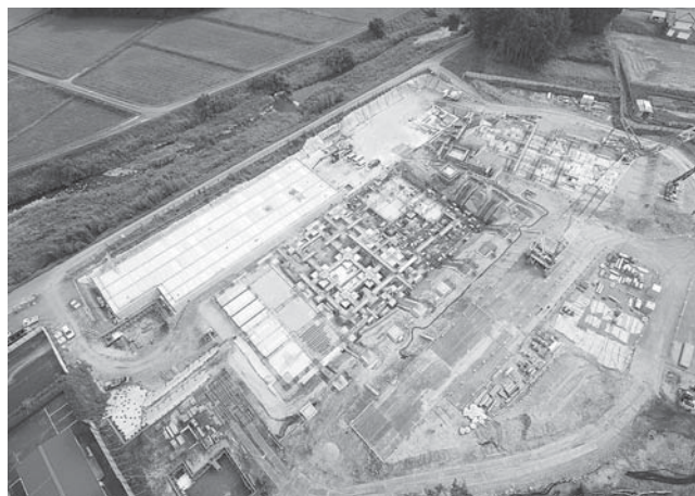
新庁舎を建設中
