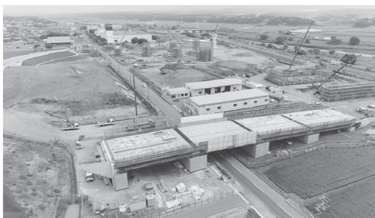
建設中の東海環状自動車道大安IC
