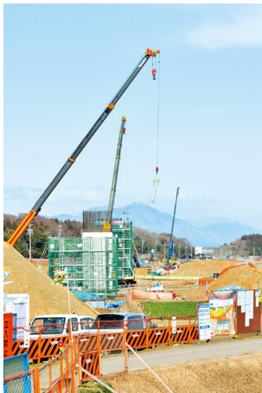
東海環状自動車道
