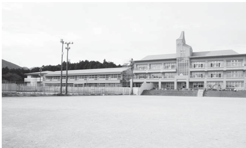
藤原中学校に隣接した藤原小学校（向かって右側が中学校、左側が小学校）
