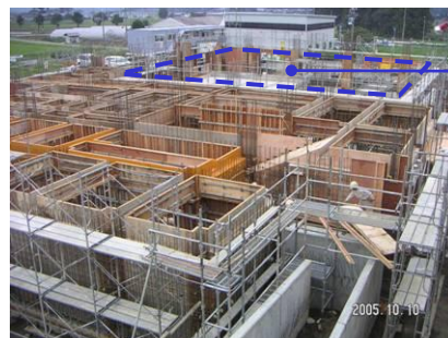
右写真) 床コンクリート打設後に作業足場を組んでいるところです。
