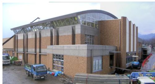
ほぼ完成した体育館の外観（北東面）
