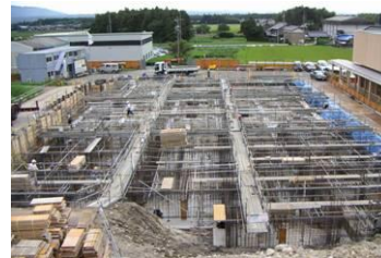
右写真) 床コンクリート打設後に作業足場を組んでいるところです。
