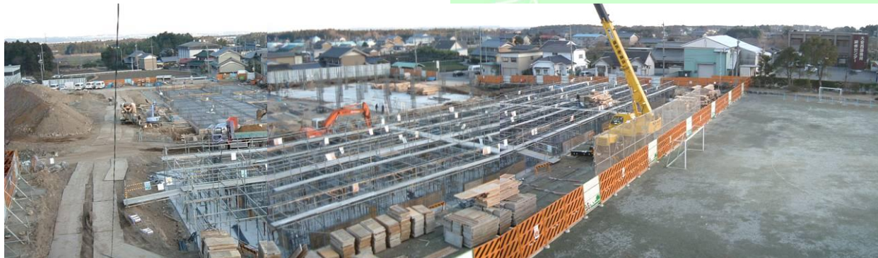
見学会当日の建設現場の様子（家庭科室より撮影）
