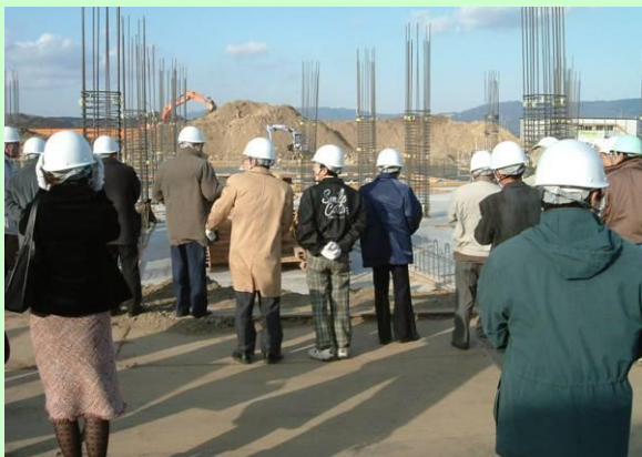
ヘルメットをかぶり現場を見学する建設委員たち
