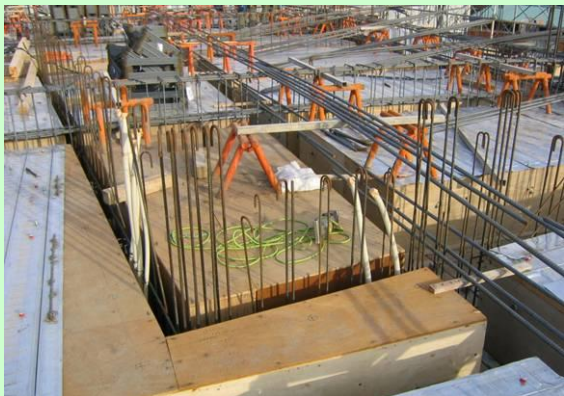
2階の床の鉄筋を組んでいる様子
