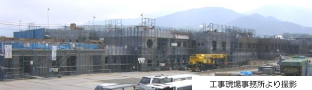
工事現場事務所より撮影
