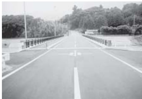
新しく完成した藤原大橋
