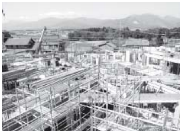
工事中の員弁西小学校 写真上は正面から 写真下は上から撮影
