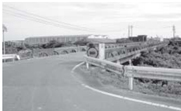
旧国道306号線の青川橋
