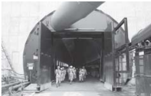
9月19日現在、約800mの掘削。
