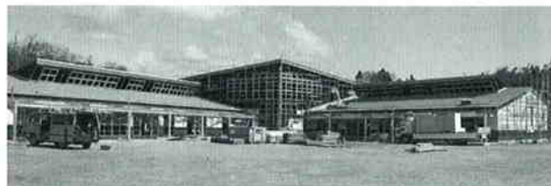
建設中の員弁西保育園
