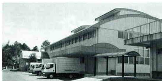
大安学校給食センター (大安中学校東)
