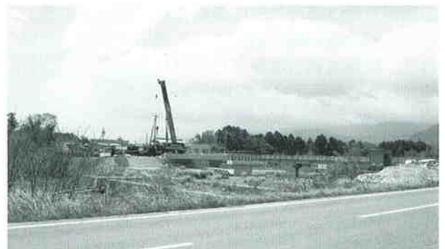
工事中的下青川橋
