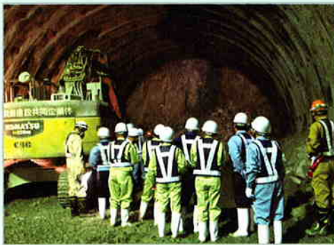
石樽峠トンネルの工事現場を視察。視察日には約300メートルの掘削でした。〈3月26日 産業建設常任委員会〉
