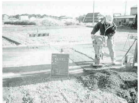
宅内接続工事の現場
