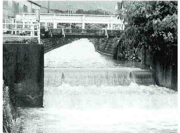
養父川に架かる馬起橋と頭首工
