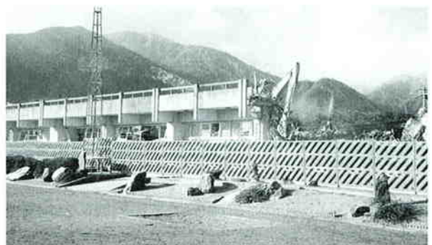
解体される旧石榑小学校校舎(平成18年1月)
