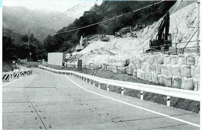
いなべ市側の工事現場
