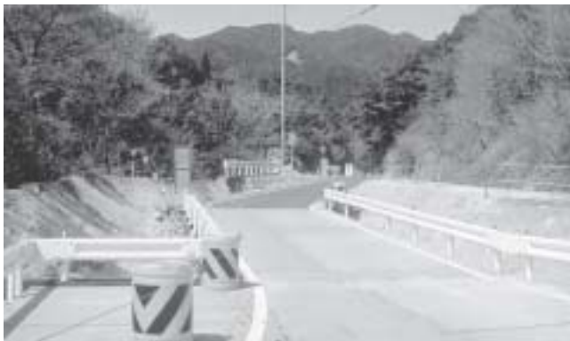
石樽峠トンネル工事のための仮設道路
