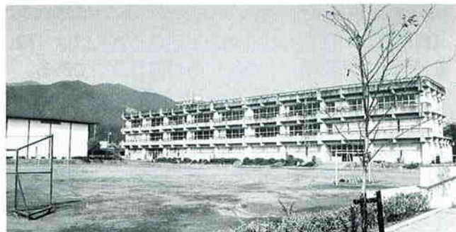
解体前の石榑小学校旧校舎
