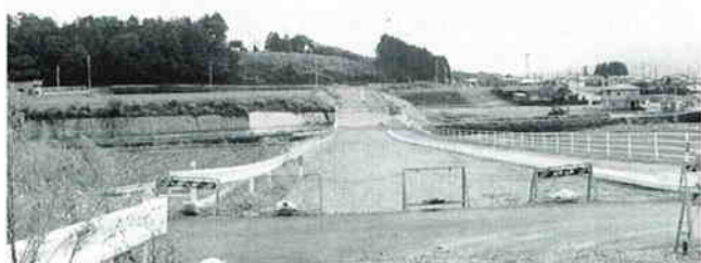
県道南濃北勢線バイパス工事現場
