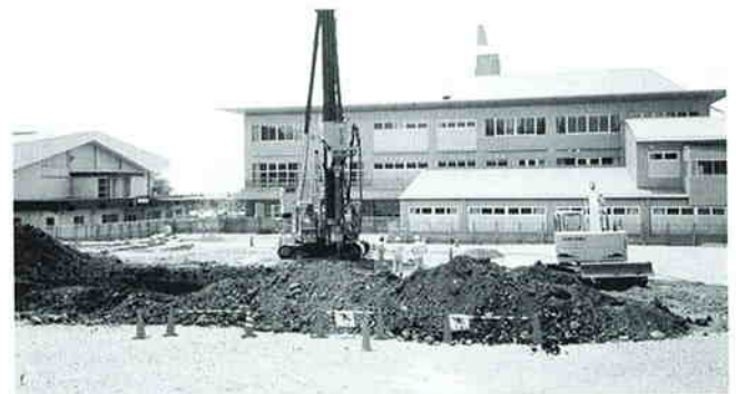
藤原中学校の工事現場
