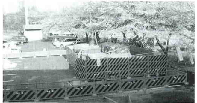
大安庁舎油漏対策復旧工事現場
