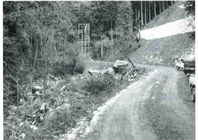
悟入谷林道治山工事現場
