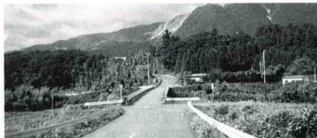
狭くて危険な藤原大橋
