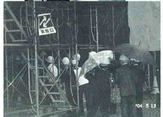
当日は、雨の中での現地視察となりました。最初の見学先は藤原中学校の校舎建設現場。第1期工事を16年6月に終え、夏休み中に引越しと既設校舎の解体が行われます。
