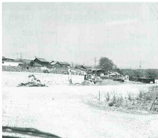
温泉施設建設予定地
