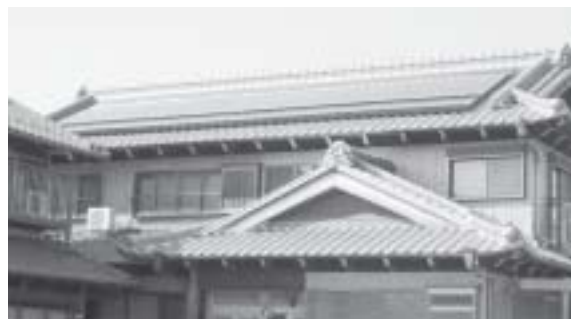
太陽光発電設備のある一般住宅
