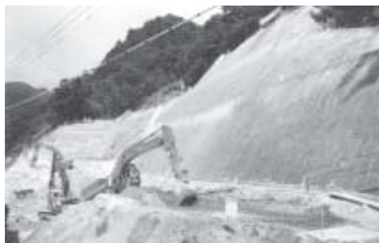
土石流復旧工事（藤原町大貝戸地区）
