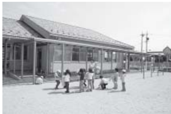
社会福祉協議会へ無償譲渡し、民営化された丹生川保育園
