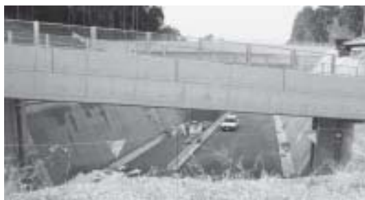
建設中の県道東貝野南中津原丹生川停車場線（鼓地内）
