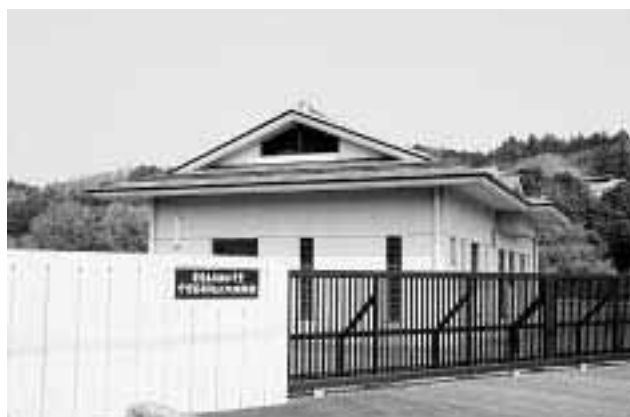
農業集落排水施設
