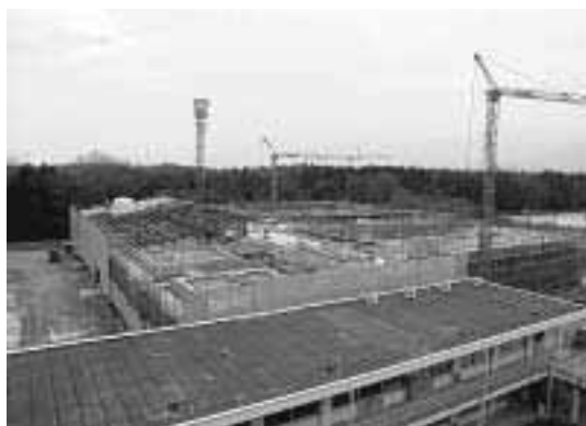
建設中の大安中学校
