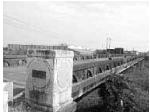
修繕を行う青川橋
