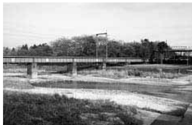
三岐鉄道三岐線宇賀川橋梁
