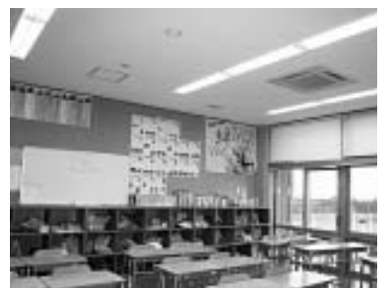
エアコンが設置されている藤原中学校教室
