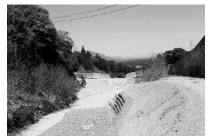
西之貝戸川4号えん堤 土砂除去後
