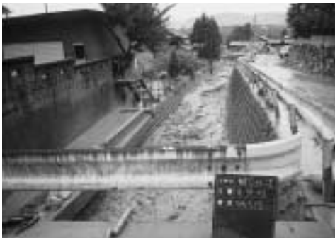
(平成14年発生 小滝川土石流)
