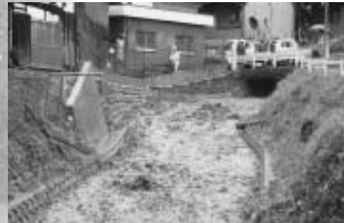
(平成14年発生 小滝川土石流)
