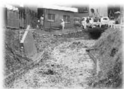
(平成14年発生 小滝川土石流)
