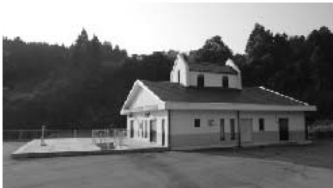
農業集落排水処理施設
