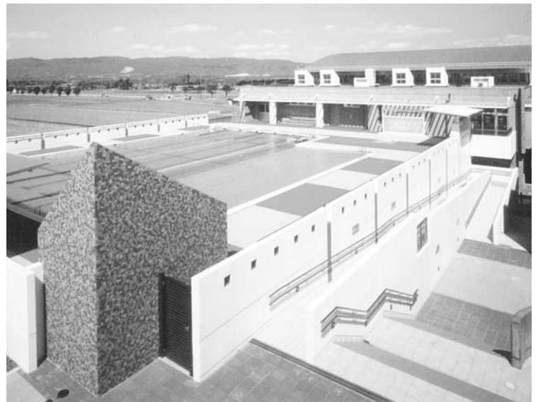
石榑小学校プール▲
