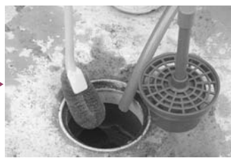
③ ホースで水圧をかけ、棒たわし等で清掃してください。
