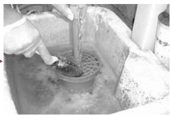
② 目皿を取り外して、溜まったゴミを取り除いてください。溜まったゴミは下水に流さないでください。
