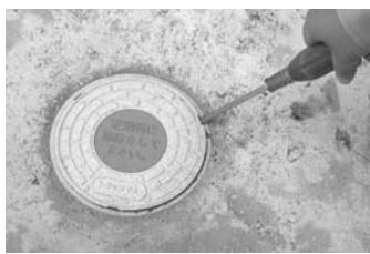
① マイナスドライバーなどを用いて、蓋を開けます。
