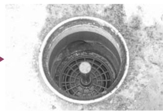
④ 目皿を所定の位置に戻し、蓋を閉めてください。
