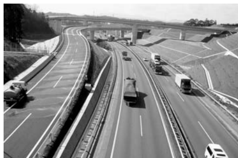
東名阪自動車道 亀山JCT [左端のランプ(取付道路)から右方向が新名神高速道路]
