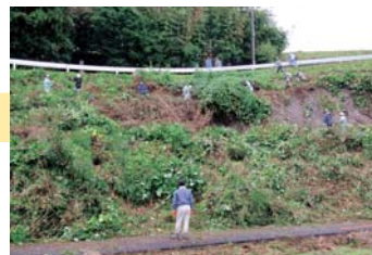
大きな法面の竹や草の伐採
