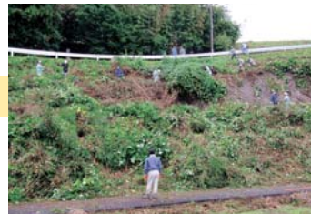
大きな法面の竹や草の伐採
