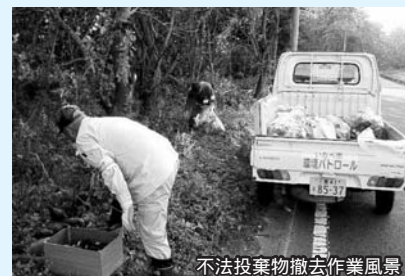
不法投棄物撤去作業風景
