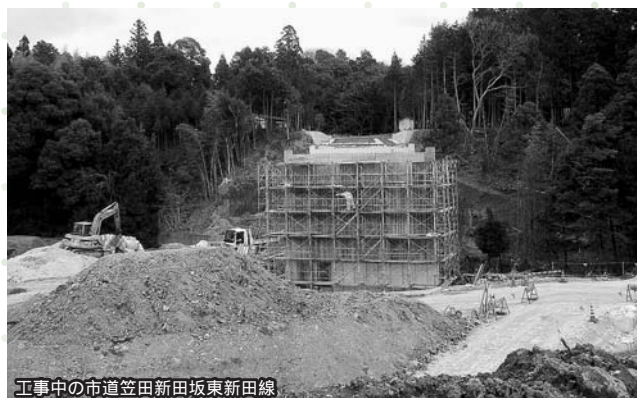
工事中の市道笠田新田坂東新田線
