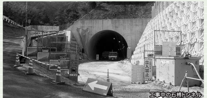
工事中の石樽トンネル
