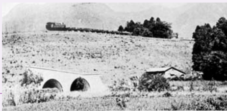
完成当時のめがね橋
