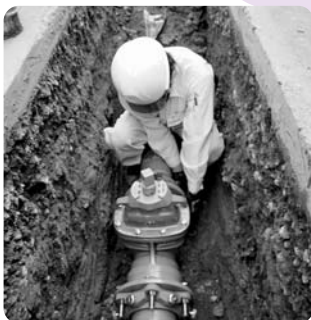
▲水道管の布設工事
