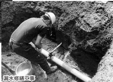
漏水修繕工事
