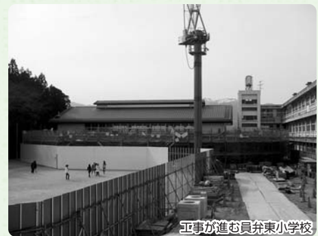
工事が進む員弁東小学校
