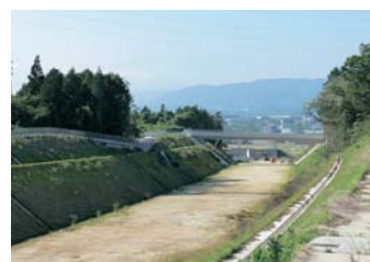
▲着々と工事が進められています。
