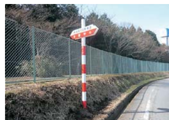
▲道路の中心杭が設置されました。
