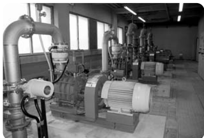
▲配水施設内の様子
