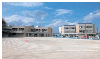
▲校舎が完成し、外構工事中の員弁東小学校
