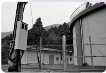
▲市内の配水施設
